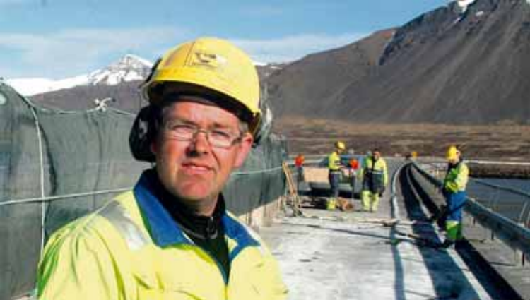
Framkvæmdir Sigurður Hallur Sigurðsson brúarsmiður á vettvangi. Brúar-gólfð er hoggð upp og ný steypa lögð í. Ein akrein opin og umferð stýrt. Morgunblaðið/Sigurður Bogi
